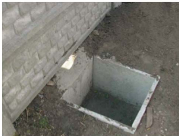
Приклад будівництва резервуару для стокових вод (із шматків парканових плит)
