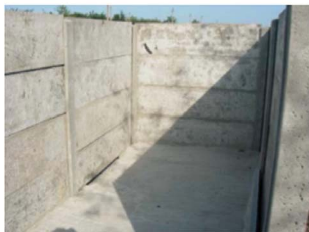
Внутрішній вигляд готового гноєсховища (із парканових плит)
